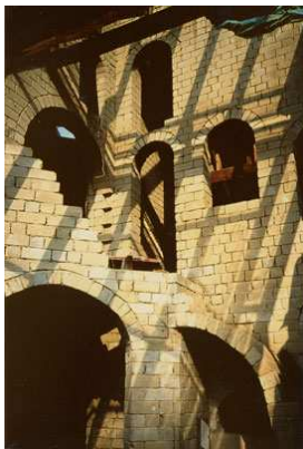
Maison conçue et construite, par l'architecte Pierre-Paul Brichant, (quartier de la Baraque à Louvain-la-Neuve) Photo de Paul De Neyer ( www.inti.be/ecotopie/ )
